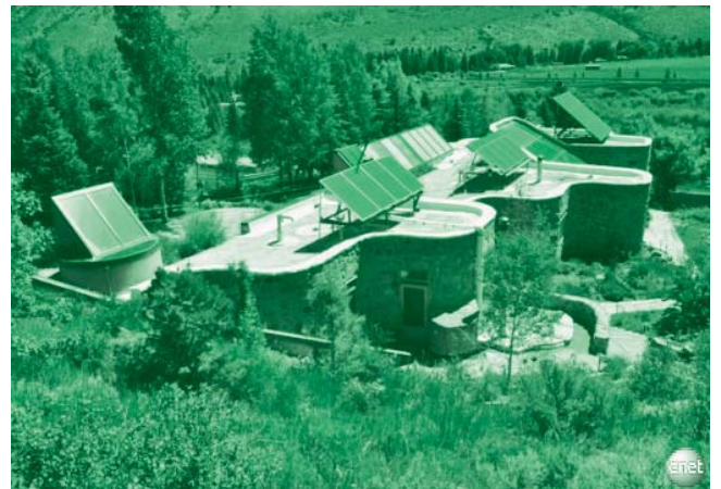
米国コロラド州にあるAmoryさんの私邸、自然エネルギー、断熱材、採光、省エネ機器を取り入れて、持続可能性を追求した家
